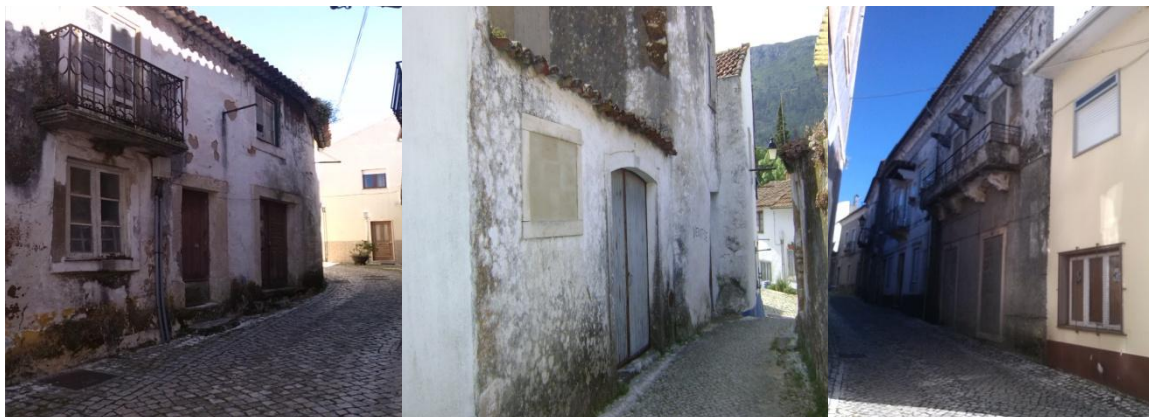
Figura 13 - Ruas desocupadas e com edifícios devolutos
