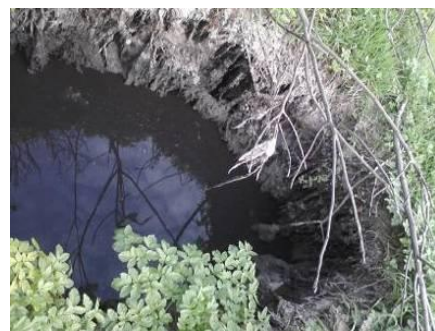
Zonas onde o colector existente colapsou.
