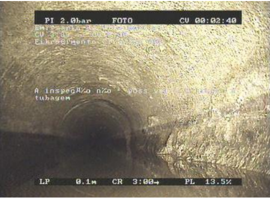
Vista geral da parede do colector e zona assoreada: VM3.039.00 e VM3.043.00.
