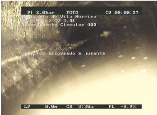
Vista geral da parede do colector e zona assoreada: VM3.039.00 e VM3.043.00.
