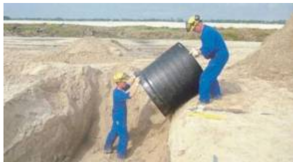
Figura 5.17 - Instalação de uma câmara de visita de polietileno (adaptada de Wavin).
