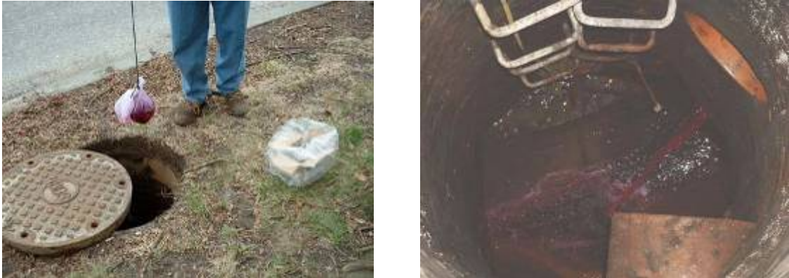
Figura 5.6 - Introdução de traçador químico numa câmara de visita de montante (esquerda) e observação na câmara de jusante (direita) (Brown et al. , 2004).
