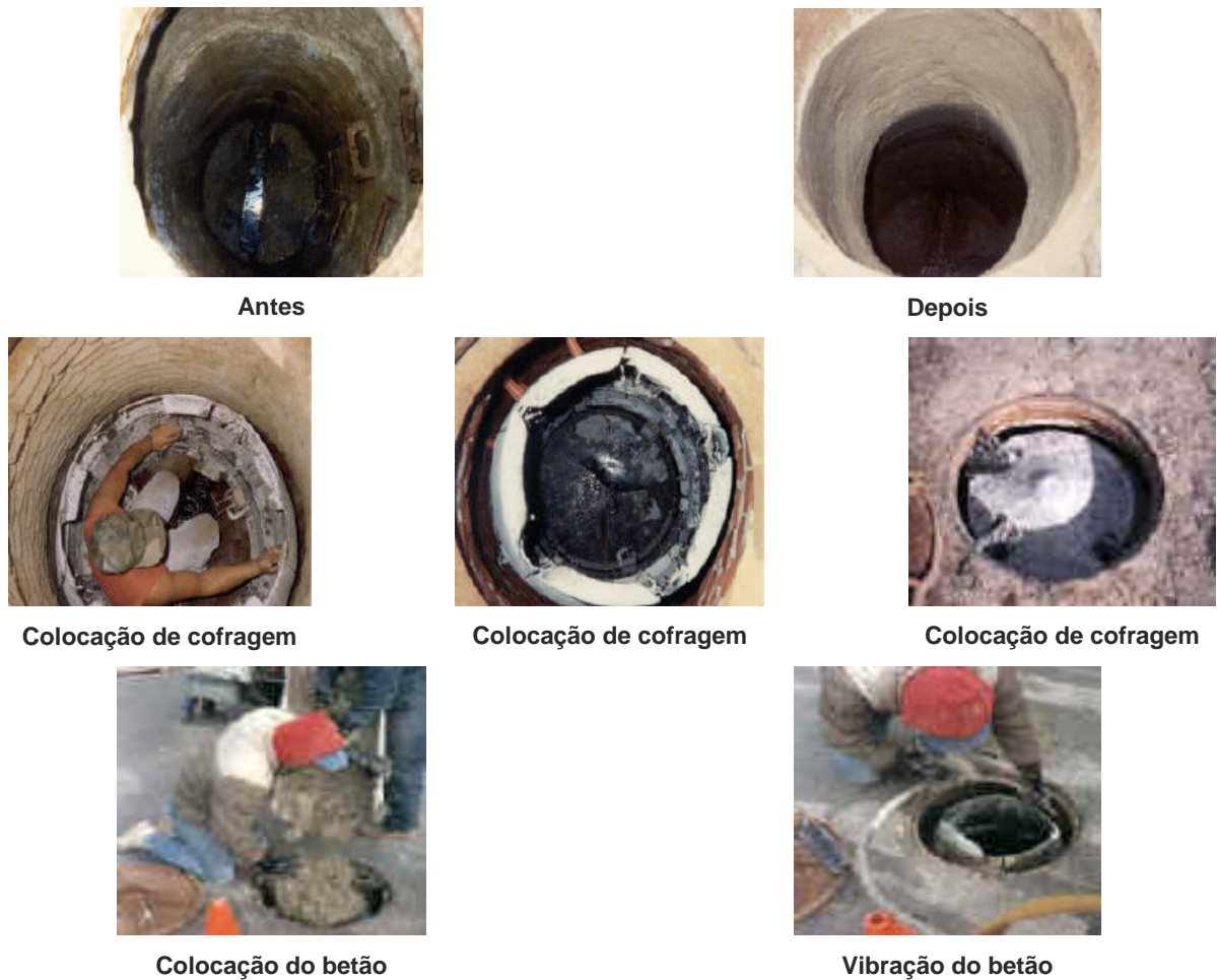
Figura 5.20 - Substituição com betonagem in situ ( www.improvedconstructionmethods.com ).
