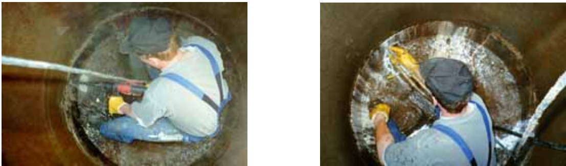
Figura 5.16 - Injecção em câmaras de visita (www.multiurethanes.com).
