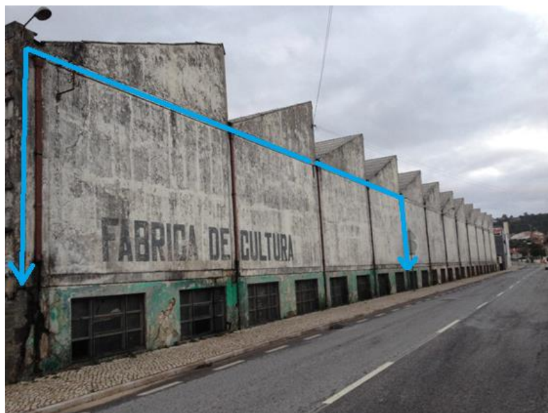
Figura 1 – Traçado de caleira e tubos de queda propostos (a azul)
